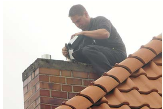
Thomas Waelisch auf dem Dach
